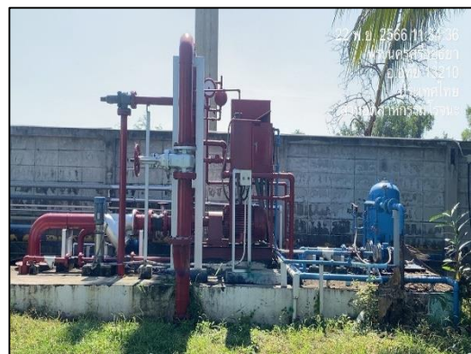
ภาพที่ 23 Fire Pump และ Jockey Pump
