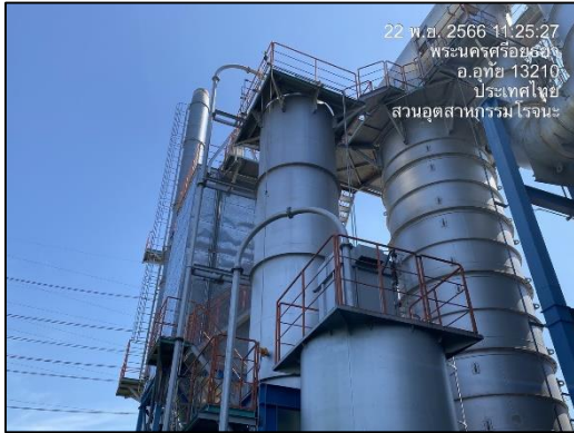
ภาพที่ 6 การควบคุมอากาศเสียในอาคารเผาไหม้ Cyclone Cooling Tower และ Bag Filter
